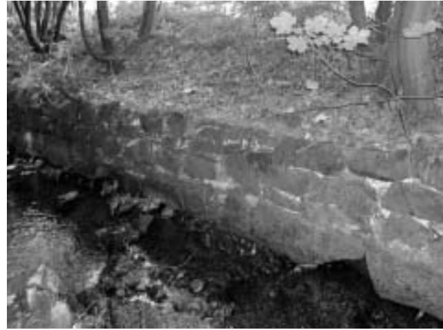
Senkrechte Ufermauer an der Langenau.
