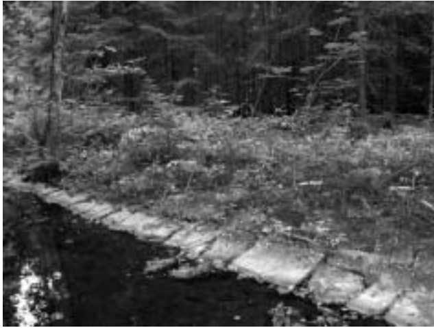
Uferpflasterung an der Langenau – in der unteren Pflasterreihe liegen besonders große Steine.
