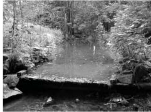
Erhaltene hölzerne Sohlschanzenkonstruktion an der Langenau.
