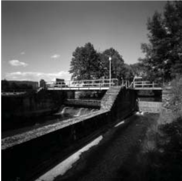
Trommelwehr mit betonierter Floßgasse von 1908 am „Schulbau“ in Küps. Während der großen Rodachregulierung von Küps erbaut, ist es eines der ältesten erhaltenen Wehre seiner Bauart.
